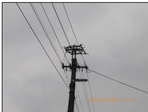
36–37. kép: Fészektartó leromlott műfészkekkel, illetve új műfészek felszerelését követően.
