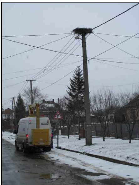
16-17. kép: Vezetékre épült gólyafészkek áthelyezés és tartóra emelés előtt, illetve utána (Selyeb).
